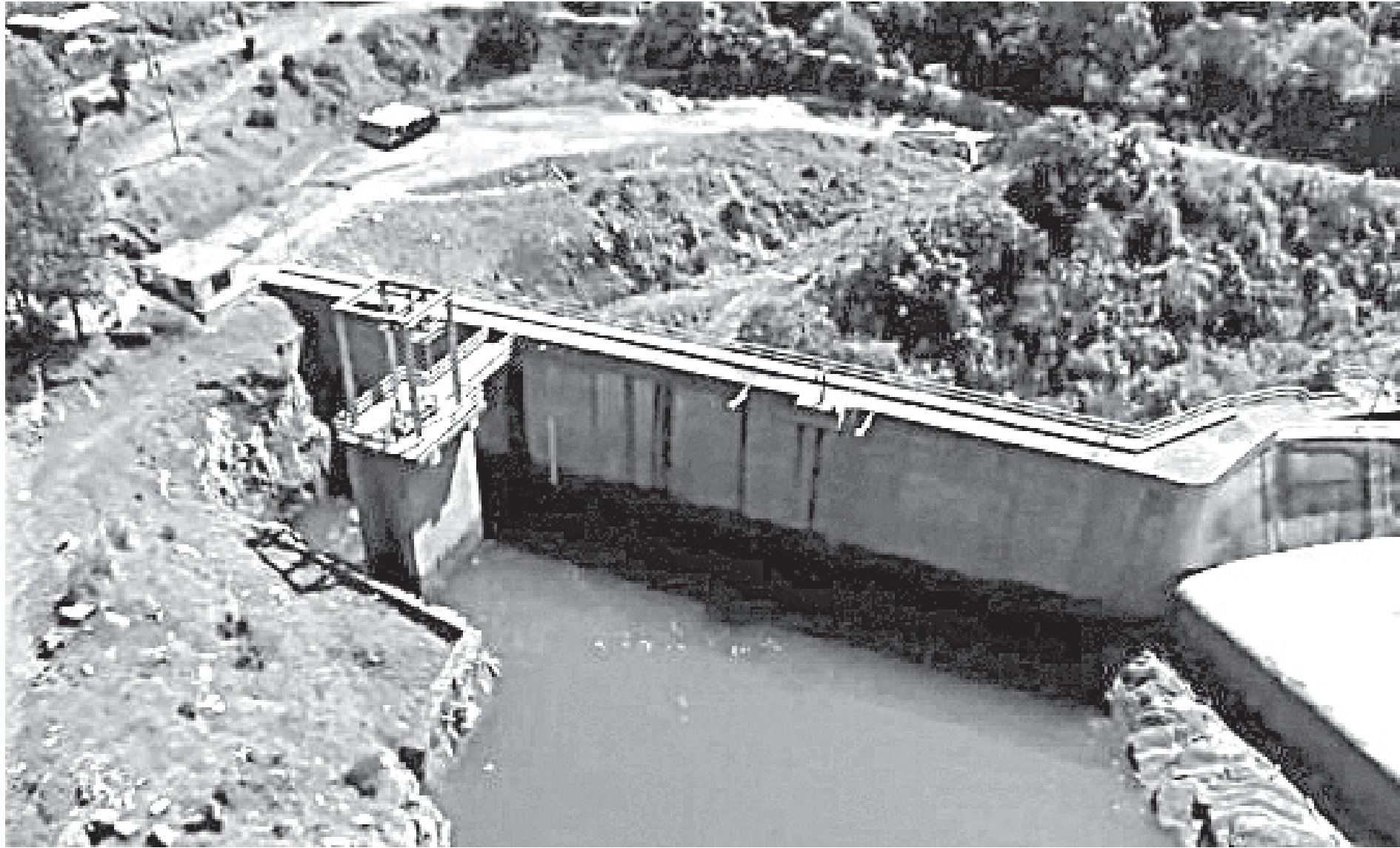
EN EL RÍO LA ANTIGUA se han retomado dos proyectos de mini hidroeléctrica.
